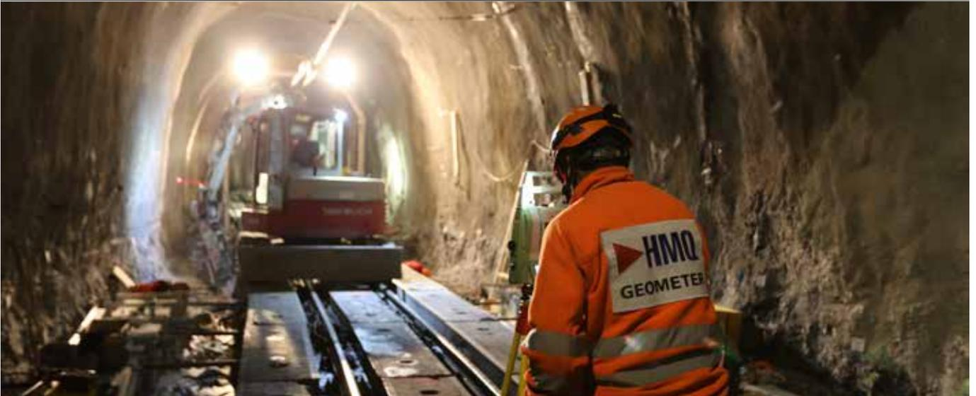
Mehr als die Hälfte der 115 Tunnels auf dem Streckennetz der RhB müssen aufgrund ihres Alters saniert werden. Die RhB entwickelte dafür ein neues, standardisiertes Instandsetzungsverfahren: die «Normalbauweise Tunnel». Dieses Verfahren garantiert geregelte Bauabläufe, tiefere Kosten als bei bisherigen Verfahren und ermöglicht die Sanierung bei laufendem Betrieb.
