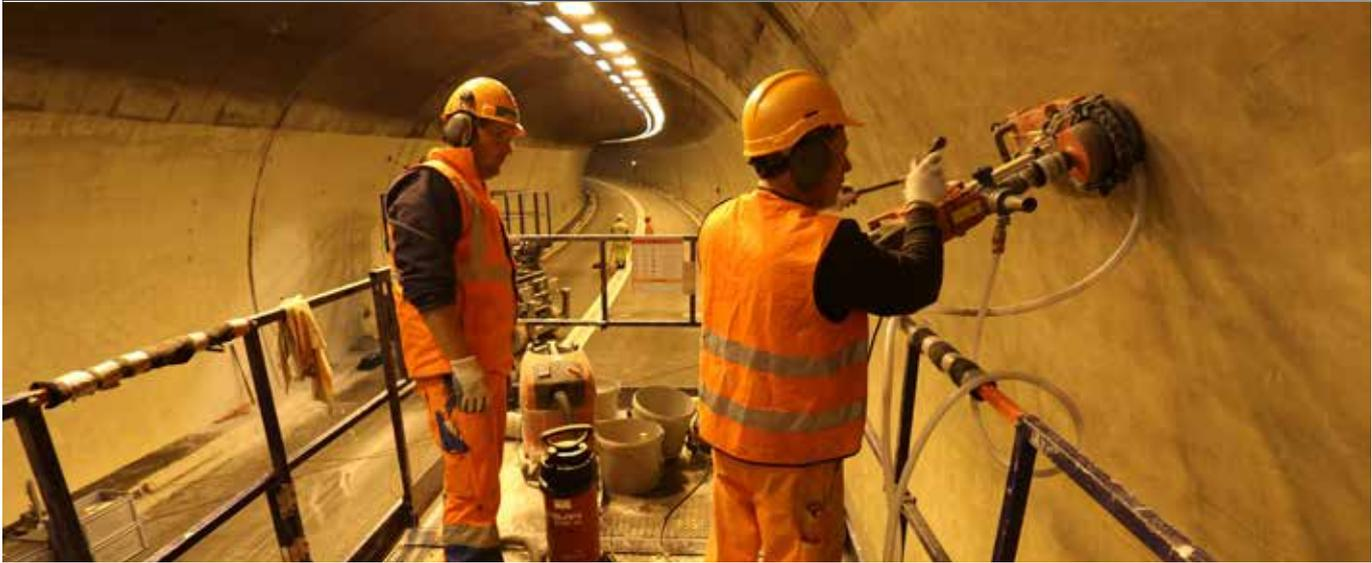
Im Rahmen von Sanierungsarbeiten hat die HMQ AG im Viamala-Tunnel ein Überwachungssystem zur Beobachtung von Bewegungen des Tunnels während dem Ersetzen von Felsankern installiert und betreut.
